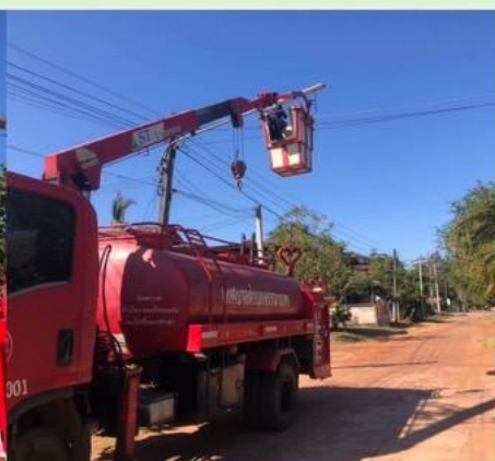
ได้รับแจ้งจากชาวบ้านหนองทุ่ม หมู่ 9 จำนวน 1 จุด เนื่องจากไฟโซล่าเซลล์ชำรุด และบ้านหนองอ้อ จำนวน 1 จุด เนื่องจากไฟฟ้า ส่องสว่างบริเวณริมถนนในหมู่บ้านขัดข้อง ทีมกองช่างจึงได้ออกซ่อมแซมไฟฟ้า เพื่อให้เกิดความสว่างในการใช้ถนน และลดอุบัติเหตุทางถนน
