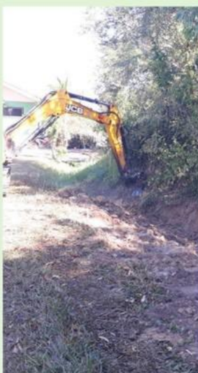
ทีมงานกองช่าง ออกขุดลอกคลองน้ำที่ตื้นเขิน และขยายถนน ที่คับแคบ ณ บ้านหนองแวง หมู่ที่ 11 เพื่อการระบายได้สะดวก และการสัญจรที่ปลอดภัยของประชาชนในพื้นที่
