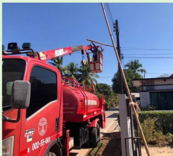
ได้รับแจ้งจากชาวบ้านนาหัวช้าง หมู่ที่ 4 จำนวน 1 จุด เนื่องจาก ไฟฟ้าส่องสว่างชำรุด ทีมกองช่างจึงได้ออกซ่อมแซมไฟฟ้า เพื่อให้เกิดความสว่างในการใช้ถนน และลดอุบัติเหตุทางถนน
