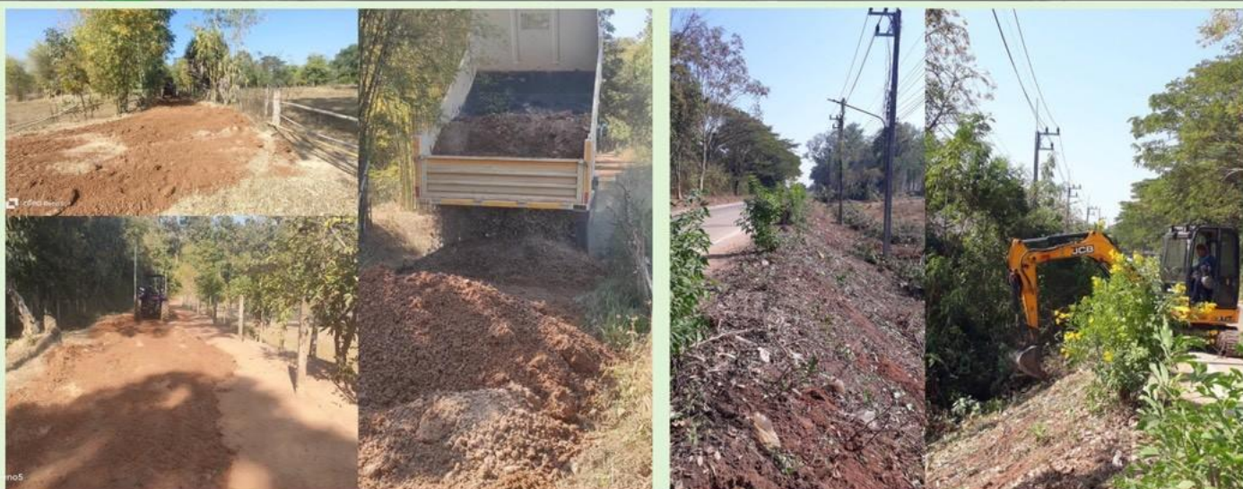
ทีมงานกองช่าง ออกซ่อมแซมถนนโดยการลงดินลูกรัง ณ บ้านบะทองใหม่ หมู่ที่ 12 เพื่อการสัญจรที่ดีเกิดความปลอดภัย
