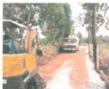
ดำเนินการแล้วเสร็จ
