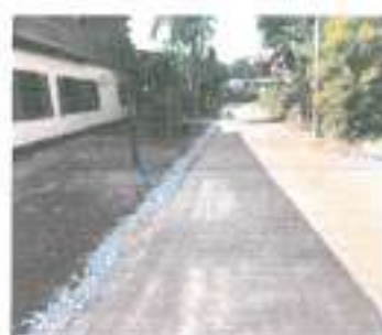
ดำเนินการแล้วเสร็จ
