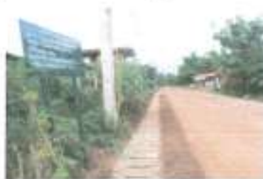
ดำเนินการแล้วเสร็จ
