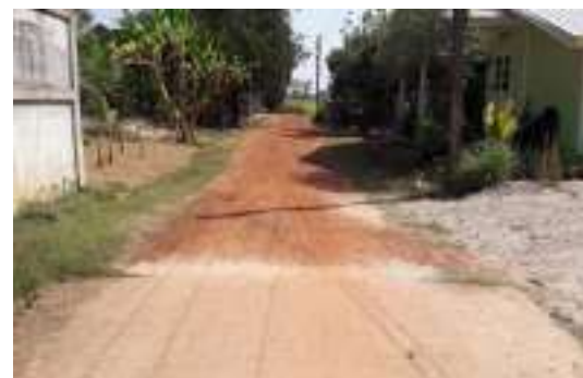
๒๗. ก่อสร้างถนนคอนกรีตเสริมเหล็กบ้านนาหัวช้าง หมู่ ๔
